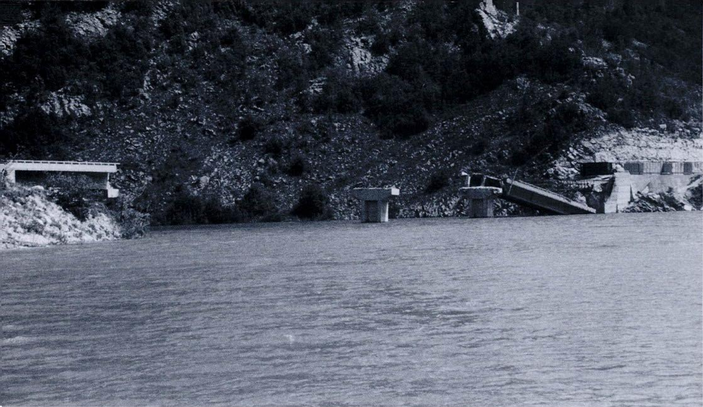
vanwege vernield viaduct
