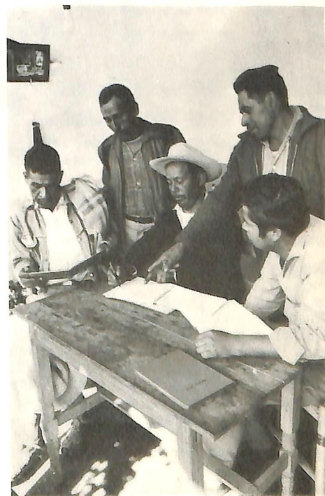
Groep arbeiders aan het werk
